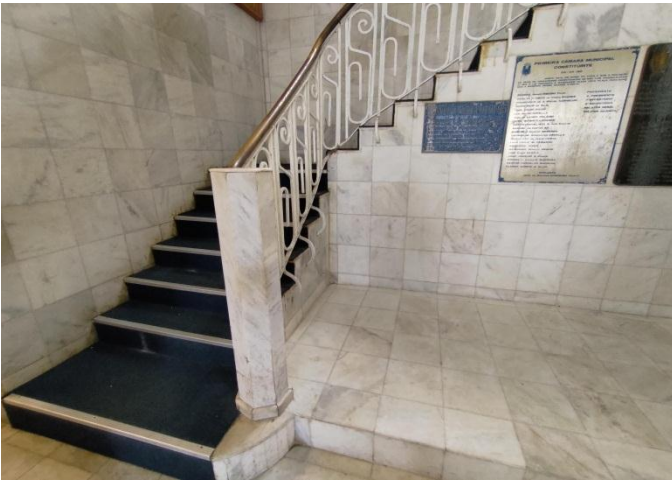
Figura 03. Vista da escada principal de acesso ao pavimento superior constituída em concreto ciclópico, com revestimento em pedra mármore e carpete. (29/08/2022)
