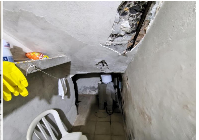
Figura 06. Vista inferior da escada principal com armaduras expostas e sofrendo corrosão, além do deslocamento do recobrimento. (29/08/2022)
