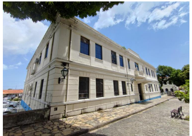
Figura 02. Vista do imóvel situado à Rua da Estrela, nº257, Qd. 103, Centro - São Luís/MA. (29/08/2022)
