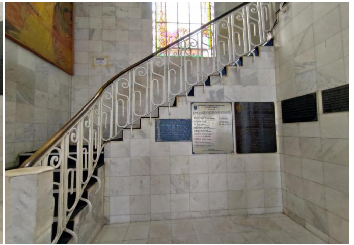
Figura 04. Vista da escada principal de acesso ao pavimento superior com corrimão e guarda-corpo. (29/08/2022)
